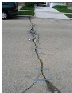
Cum să repară crăpăturile din asfalt
